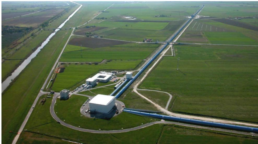
**Figura 3.1:** Observatório de ondas gravitacionais VIRGO: um interferômetro de Michelson com braços gigantesco de 3km de comprimento (ainda multiplicados por um fator 200 por meio de idas e voltas da luz numa cavidade ótica). Crédito: The VIRGO Collaboration, <https://en.wikipedia.org/wiki/Virgointerferometer>.
